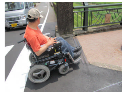
施工後 (スムーズに歩道にあがれます)
