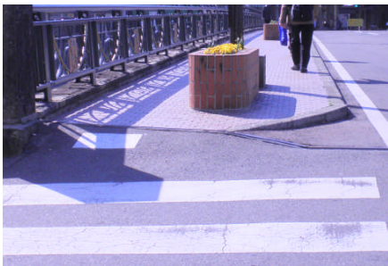
施工前 (橋と道路のスロープがきつかった)
