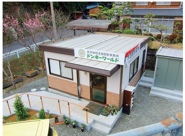
▲利用者に快適に作業をしてもらえるように、水洗トイレや大型エアコンも完備。
